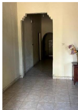
FIGURA 7 - Piso de cerâmica. Fonte:
