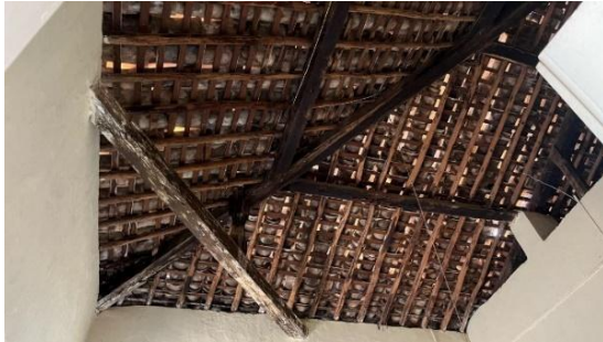
FIGURA 03 - Cobertura com estrutura original.
