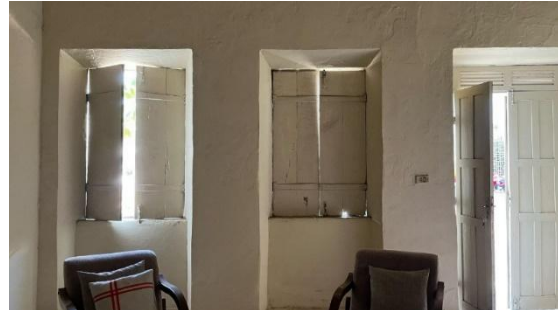
FIGURA 04 - Chanfros internos das alvenarias.
