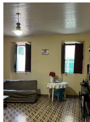
FIGURA 9 - Forro de P.V.C. e ladrilho.
